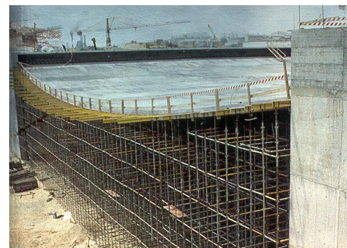
Fig a 10 – Cavalete e Cofragem da “Pala”
