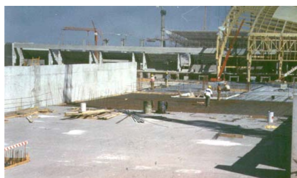
Fig a 18 – Betonagem da Lâmina de Compressão
