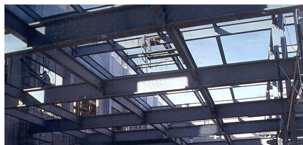
Fig a 16 – Estrutura Principal do Pavimento
