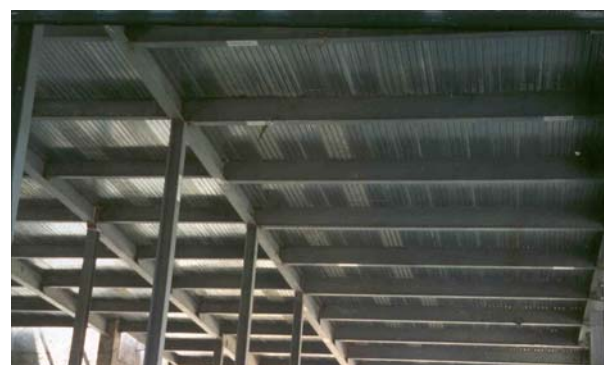
Fig a 17 – Vista Inferior das Chapas Colaborantes
