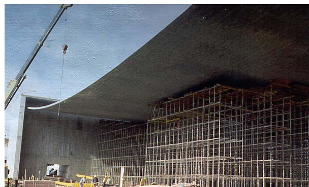
Figª 14 – Descimbramento da “Pala”
