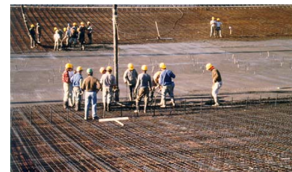
Fig a 12 – Operação de Betonagem da “Pala”
