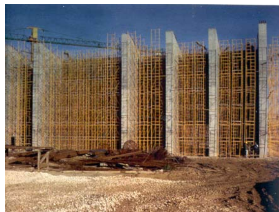
Fig a 9 – Construção dos Contrafortes
