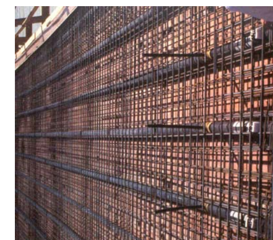
Fig a 11 – Bainhas dos Cabos e Armaduras
