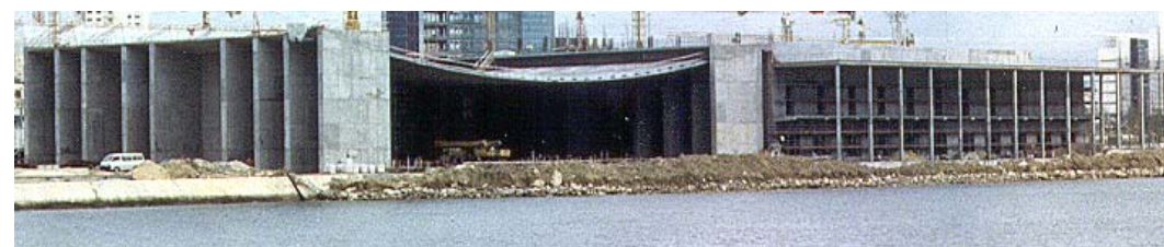
Fig a 2 – A “Pala” e o Pavilhão – Vista Durante a Construção
